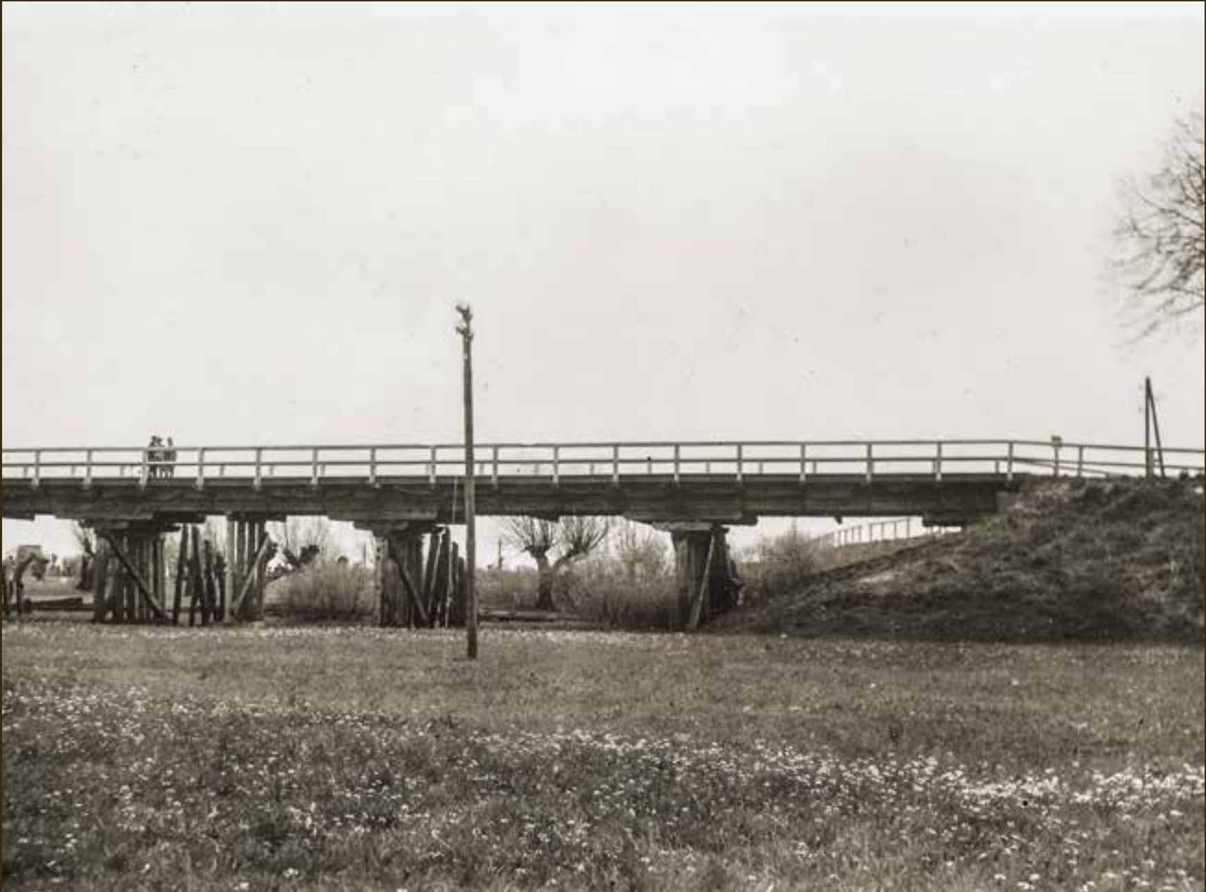
Die alte Flutbrücke (Holzkonstruktion) um 1932.
