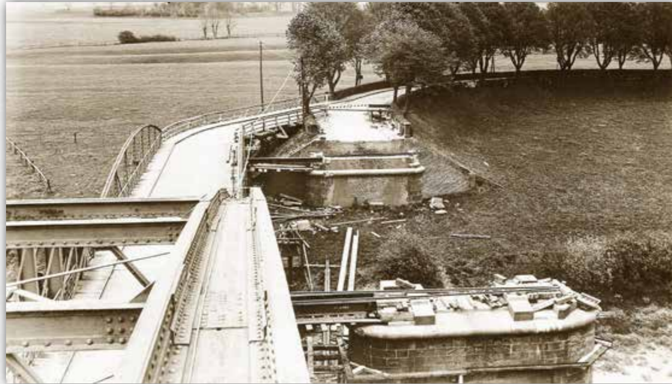
Versatz der alten Brücke auf Hilfspfeilern und Anschluss an die Landstraße nach Verden
