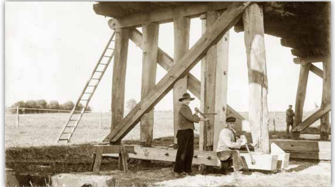
Zimmermänner beim Abbau
