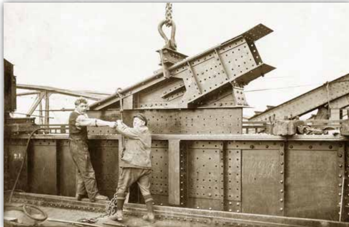
Detailansicht der neuen Weserstrombrücke
