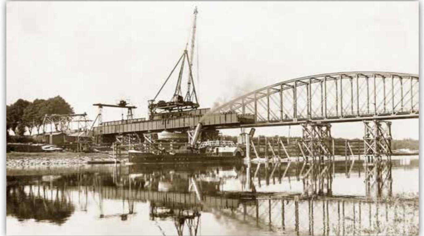
Bau der neuen Weserstrombrücke auf den alten Pfeilern
