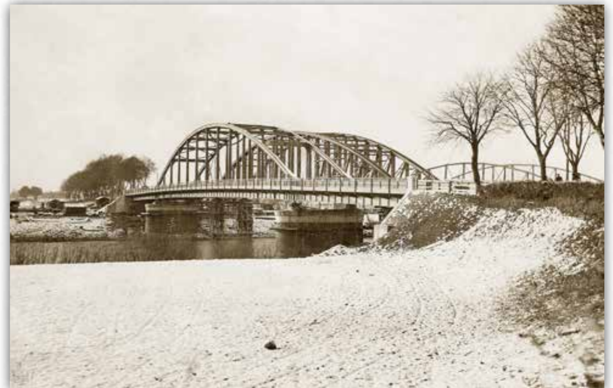
Nach Fertigstellung der neuen Brücke wurde die alte Brücke vor Ort abgebrochen
