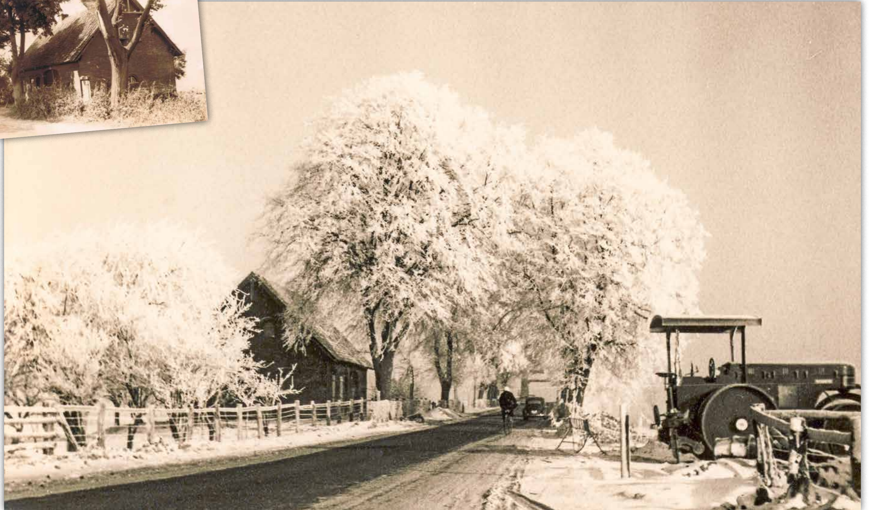
Die Auffahrt zur Weserbrücke in Hutbergen (1963) | Kleines Bild: Ansicht des ehemaligen Hauses an der Auffahrt (um 1950)
