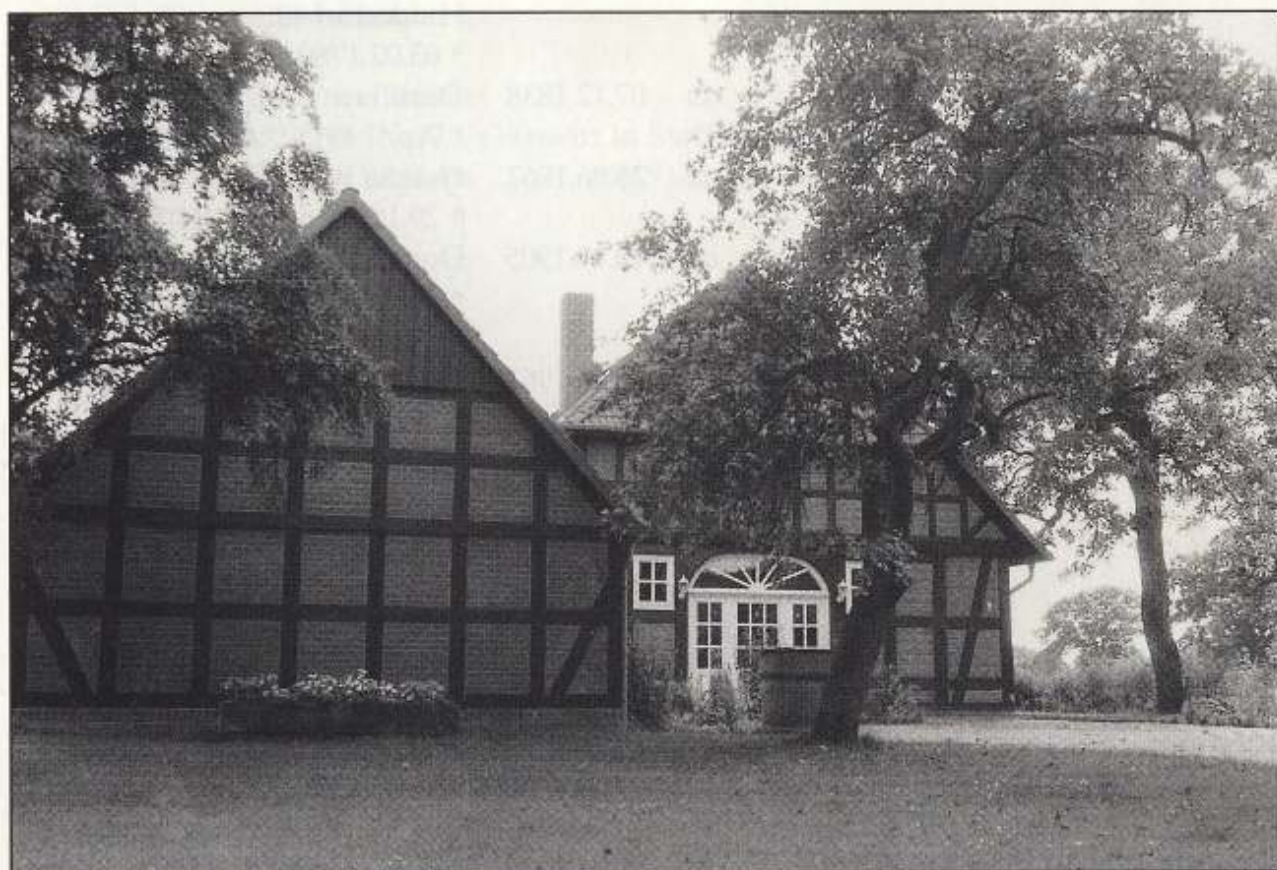
(Blender-) Varste Nr. 33. Die Gebäude wurden 1993 durch Feuer infolge Blitzschlages teilweise vernichtet. Beim Wiederaufbau wurden die Außenansichten weitgehend dem früheren Zustand folgend rekonstruiert. (Foto: E. Rosenhagen)
