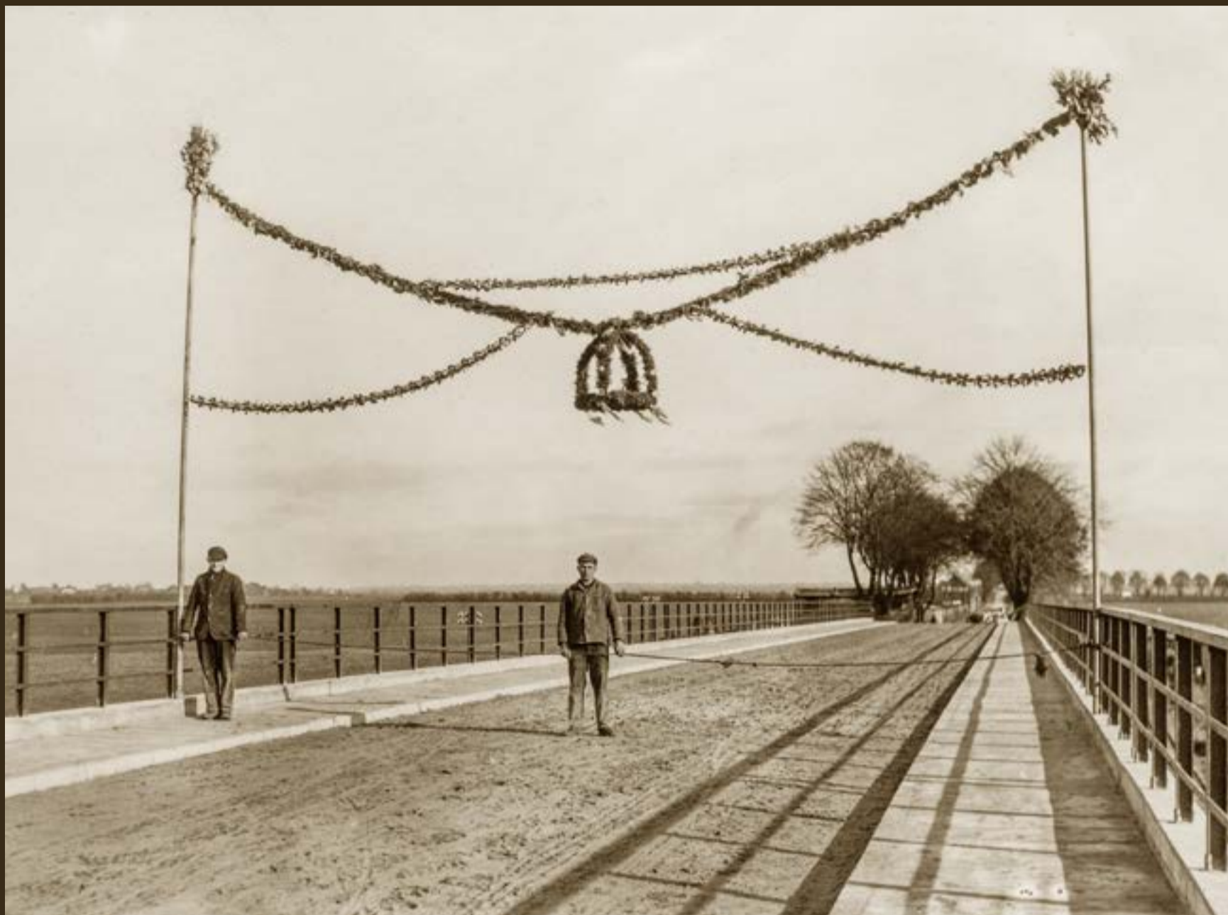
Einweihung der neuen Flutbrücke am 01. November 1932.
