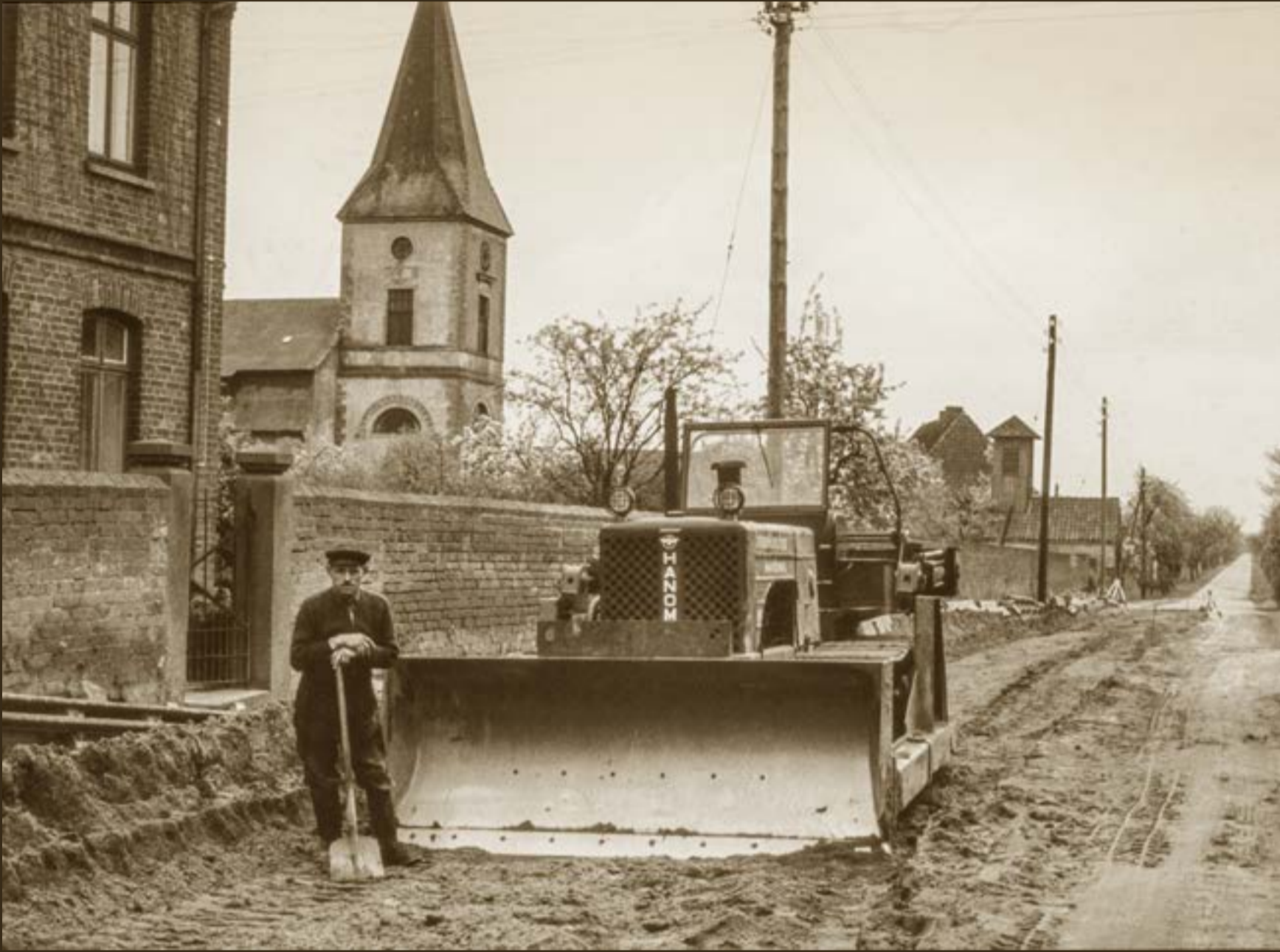
Ausbau der Intscheder Dorfstraße im April 1959.
