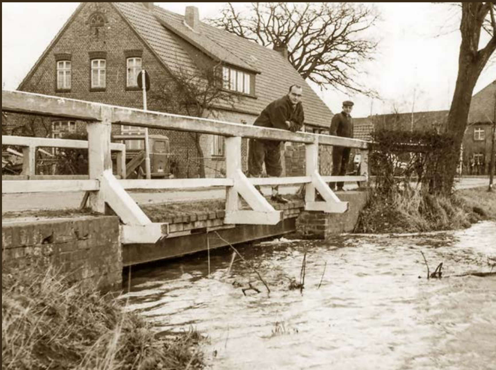
Hochwasser der Landwehr in Einste um 1960. Hinten rechts das ehemalige Gasthaus Bischof.
